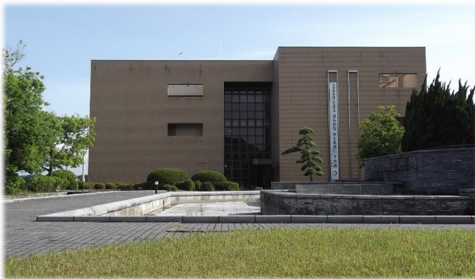
写真 取手地方広域下水道組合管理棟
