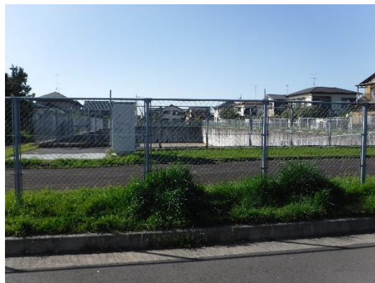
写真 谷井田第1排水ポンプ
