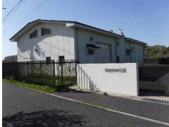
写真 ゆめみ野汚水中継ポンプ場
