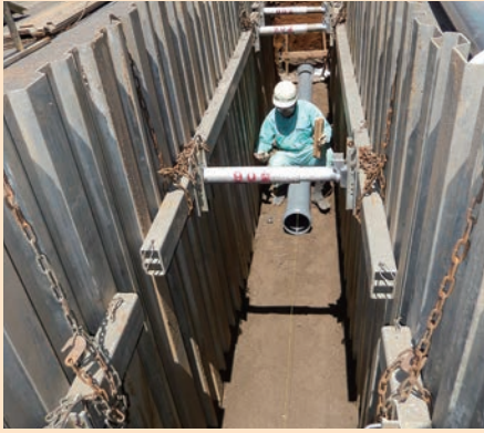
道路を掘り下水道管を設置している写真です。自然に流れるよう勾配（傾き）に注意して作業をしています。
