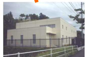
稲汚水中継 ポンプ場
