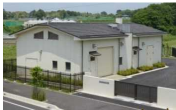
ゆめみ野汚水 中継ポンプ場
