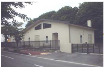
野々井汚水中継 ポンプ場
