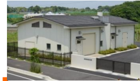
ゆめみ野污水中継ポンプ場
