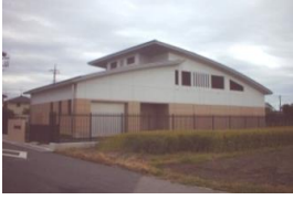
山王新田污水中継ポンプ場
