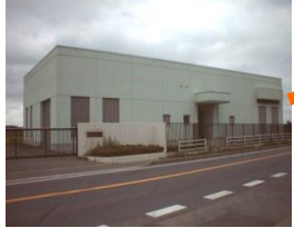
稲污水中継ポンプ場
