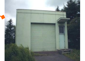
高須污水中継ポンプ場
