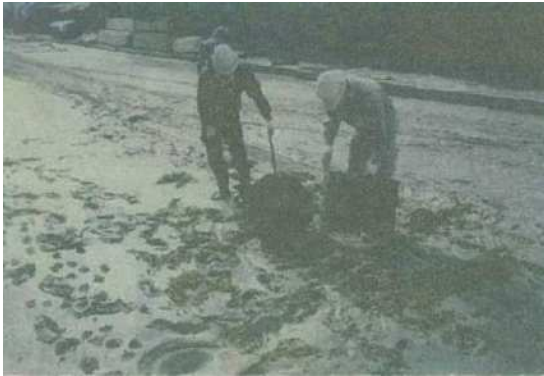
写 2.4.1 噴砂の状況（兵庫県南部地震）
